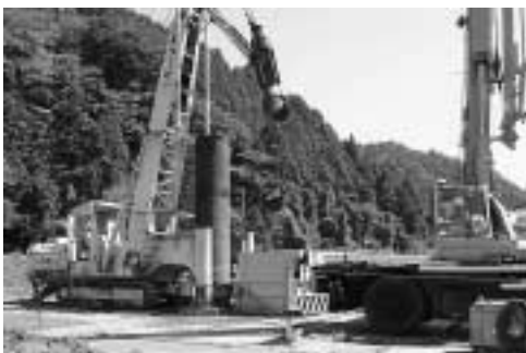
第四次拡張事業（平井4号井戸掘削）
