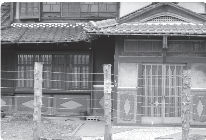
駅前民家現状
