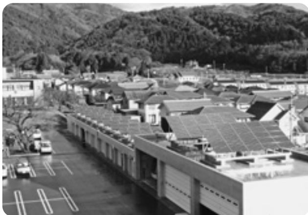
▲太陽光パネル
