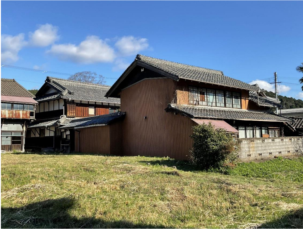
③ 母屋、物置、離れ小屋 南側から写
