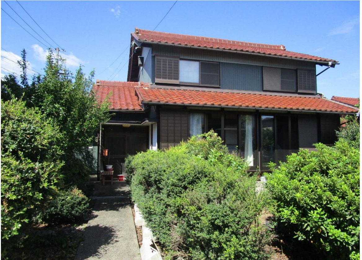
【外観全景写真】
