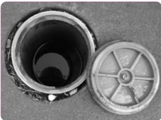
▲管内の詰まりによるマス内の滞留状況
