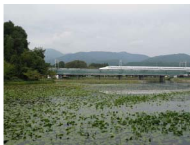
JR 東海道新幹線高架と 十九女池
