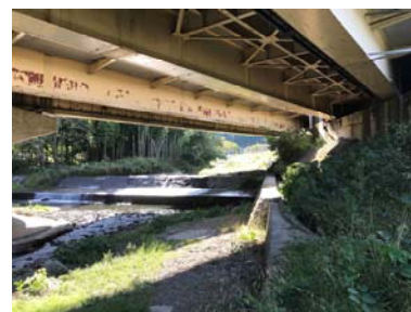
今須川と 名神高速道路の橋りょう
