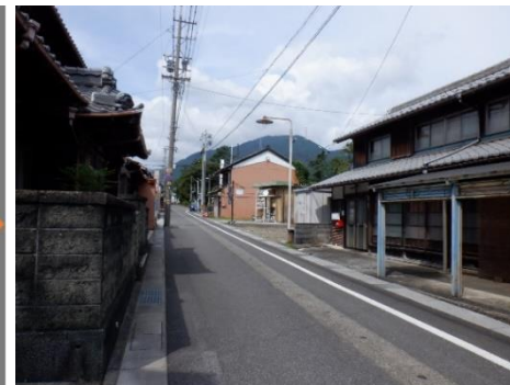
▲消雪管と瓦屋根のまちなみ
