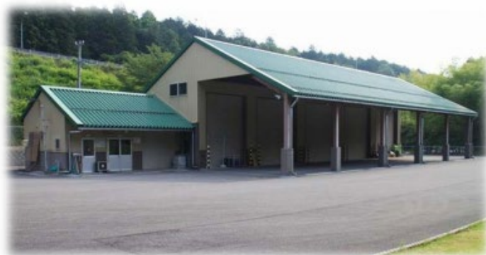
関ヶ原町資源物ストックヤード
